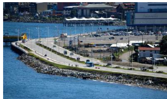
FOTOGRAFÍA 26: COSTANERA PUERTO MONTT, SECTOR MALL COSTANERA.
