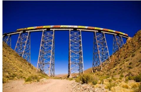
locomotora negra que estaba detenida sobre el viaducto La Polvorilla y largaba dos enormes chorros de vapor blanco que contrastaban con el azul del cielo. El punto final del recorrido es el kilómetro 1350 donde se encuentra el viaducto La Polvorilla de 224 metros de longitud por 63 de altura. Es el más elevado de toda la línea del convoy, a 4200 metros sobre el nivel del mar y uno
