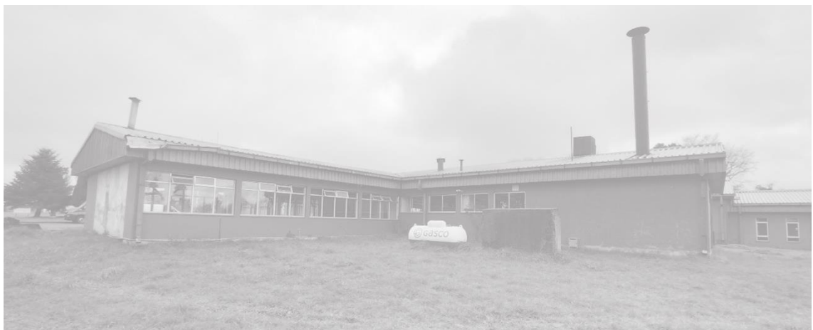
Fotografía 1: Estado actual de edificio de Ex casino CIC Los Ríos. Fuente: LEU.
